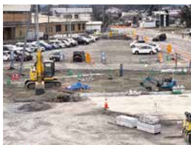
大更駅前周辺整備事業の現状
