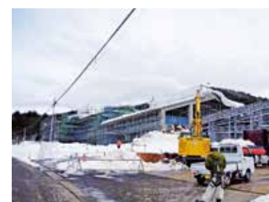
建設中の校舎と寮(共に3階建て)
