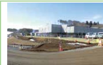
統合保育所の建設状況
