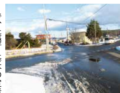
見通しが悪い危険な変則交差点
