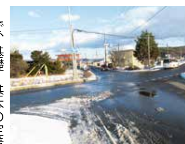
見通しが悪い危険な変則交差点
